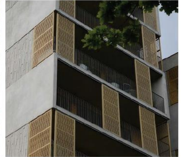
Fönstersättning, balkonger och solavskärmning ska på ett medvetet sätt bidra till att dela in och levandegöra fasaderna.
