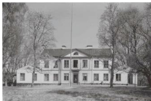
Norrby Gård, nedbrunnen 1959
