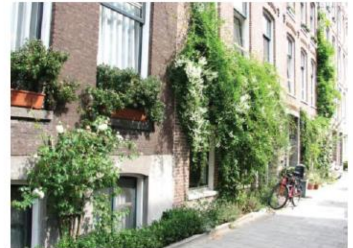
Gröna väggar och växtlighet i fasaderna utgör ett positivt inslag i både gårds- och gatumiljön samt bidrar med positiva klimateffekter.
