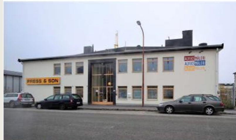
Kontors- och fabriksbyggnaden på fastigheten Båglampan 33.
