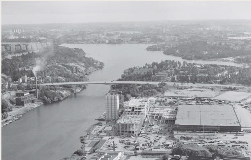
Pripps bryggeri under uppförande. Huvudstaleden är byggd och de nya bebyggelsevolymerna samspelar tydligt med Solnaverket på andra sidan Bällstaviken. Foto Erik Claesson, Riksantikvarieämbetet 1968.
